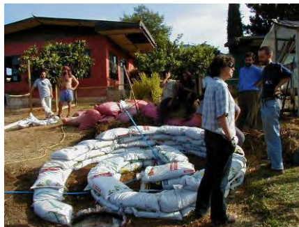
Construccion de huerto organico en espiral con sacos de arena y revestido con barro.
