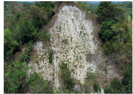
Deslizamiento, Los Álveos, Coclé, Panamá.
